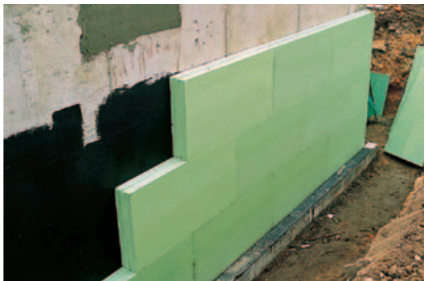
Obr. 5: Kladení desek Styroduru® C na vazbu.
