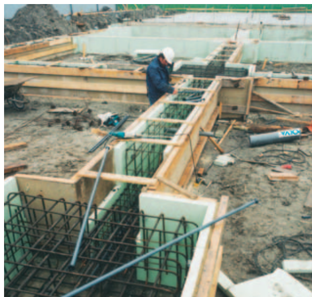
Obr. 15: Bednění se Styrodurem C.
