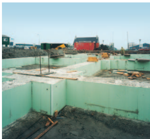
Obr. 16: Desky z materiálu Styrodur C nastavené do bednění.
