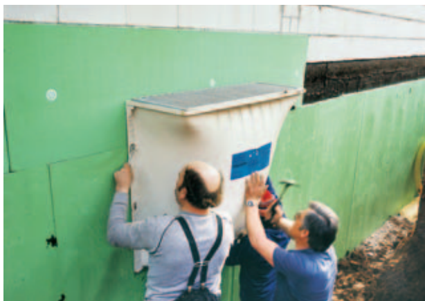
Obr. 3: Izolace suterénu Styrodurem® C.
