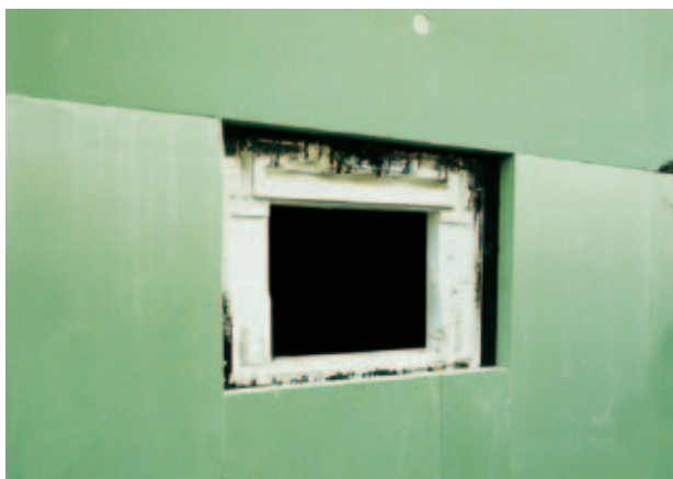
Obr. 4: Izolační opatření s použitím Styroduru C.
