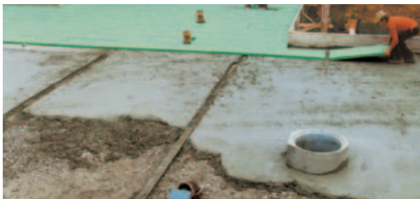
Obr. 18: Podkladní vyrovnávací vrstva z hubeného betonu pro pokládku podlahové izolace.
