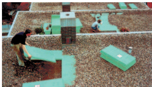
Obr. 5: Uložení izolační vrstvy pod štěrkem.
