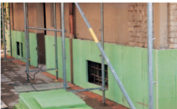
Obr. 12: Dodatečná izolace soklu materiálem Styrodur® 2800 C.
