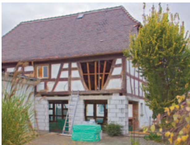
Obr. 19: I na tuto budovu byl také použit materiál Styrodur® C k tepelné izolaci podlahy.
