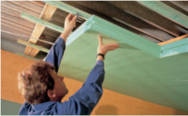
Obr. 10: Montáž samonosného podhledu.
