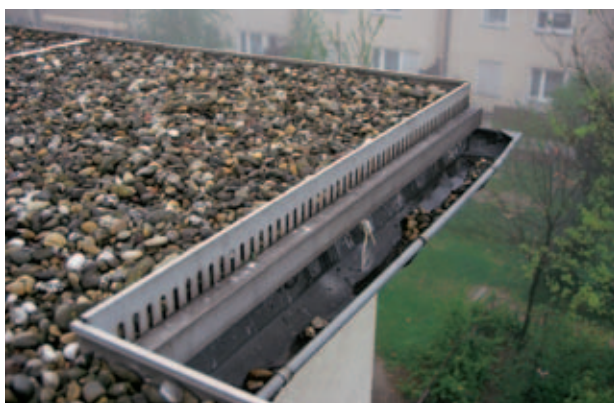
Obr. 7: Štěrková sřecha na materiálu Styrodur® C.
