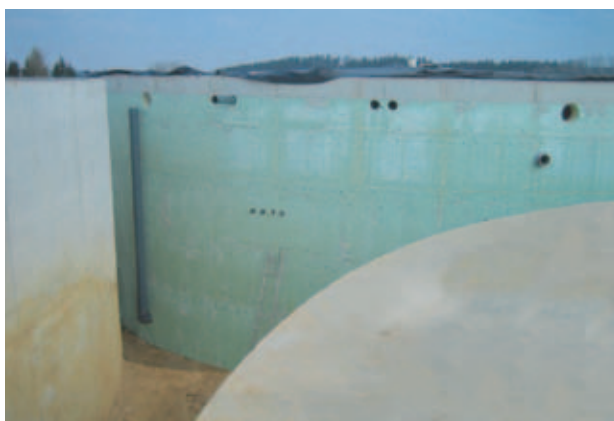
Obr. 1: Tepelná izolace z materiálu Styrodur® C na stěně zařízení pro kvašení zhotovené z železobetonu.
