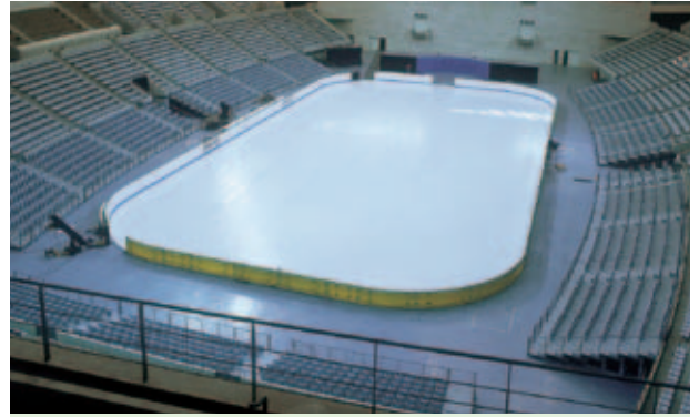
Abb. 16: Styrodur C unter einer Eislauffläche.
