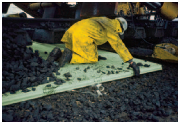
Abb. 9: Verlegung von Styrodur C im Gleisbett.
