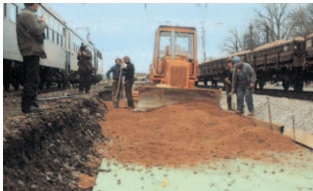
Abb. 8: Frostschutz im Gleisbettbau mit hoch druckfestem Styrodur C.
