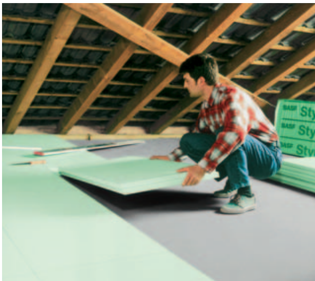
Abb. 10: Dämmung eines Dachraumes mit Styrodur® C.
