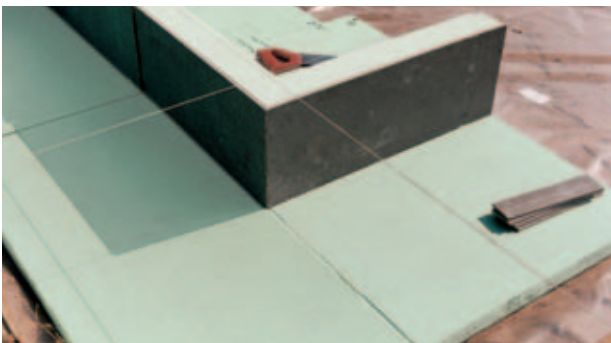
Abb. 3: Dämmung einer Gründungsplatte mit Styrodur® C.
