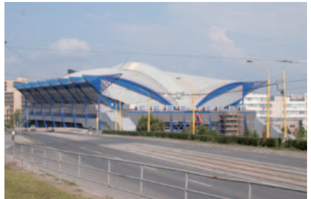
Abb. 17: Referenz: Steel Arena in Košice (Slowakei). In der neuen Eishockey-Halle wurde Styrodur C unter der Eisfläche verlegt. Hier wird die Eishockey-Weltmeisterschaft 2011 stattfinden.
