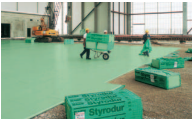
Abb. 23: Dämmung eines Hallenbodens mit Styrodur® C.
