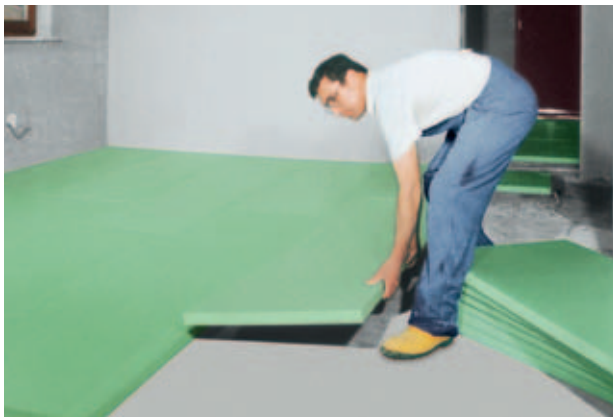
Abb. 19: Dämmung eines Kellerbodens.
