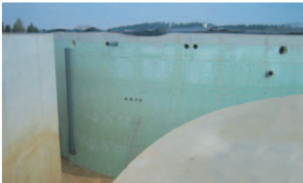
Abb. 1: Wärmedämmung aus Styrodur® C an einer Fermenterwand aus Stahlbeton.
