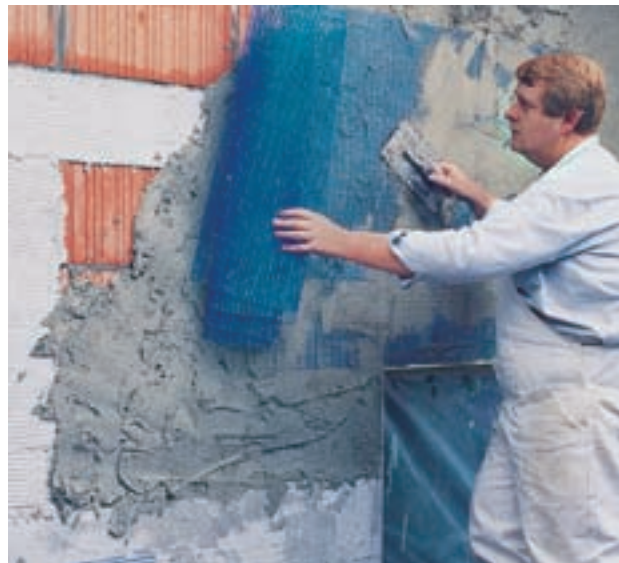
Fig. 22: Aplicación del fondo de enfoscado e instalación del refuerzo del tejido de fibra de vidrio sobre la construcción de hormigón aislada.
