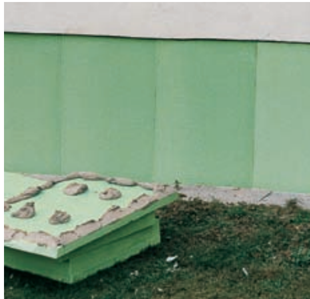
Fig. 31: Rehabilitación de edificios antiguos; Pegado de planchas de Styrodur 2800 C con procedimiento de pelladas.
