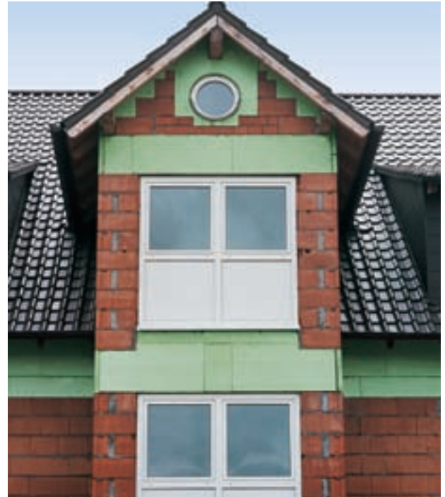
Fig. 1: Aislamiento de puentes térmicos de construcciones de hormigón: – Saliente del tejado – Caballete de la cumbre – Forjado – Dintel de la ventana – Borde del techo
