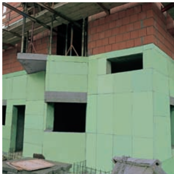
Fig. 25: Aislamiento de una gran superficie de una planta baja con planchas de Styrodur C.
