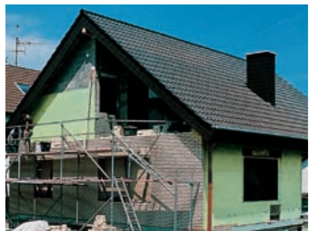
Fig. 39: Aislamiento entre hojas con Styrodur C.
