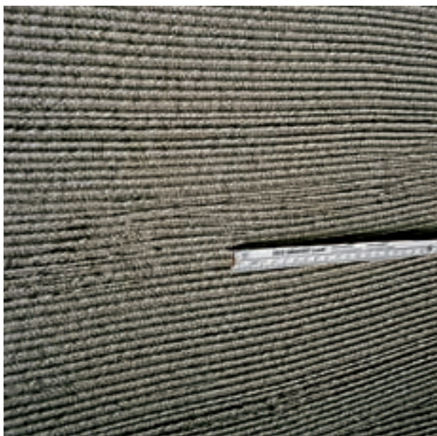
Fig. 24: Puente de unión aplicado de forma horizontal sobre aislamiento de Styrodur® C.
