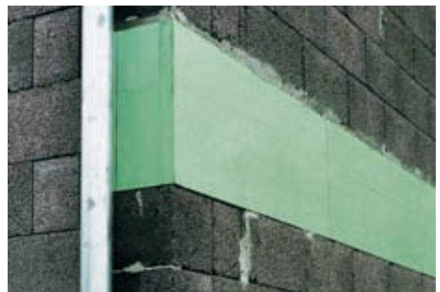
Fig. 2: Aislamiento térmico en el frente del forjado con Styrodur® 2800 C.
