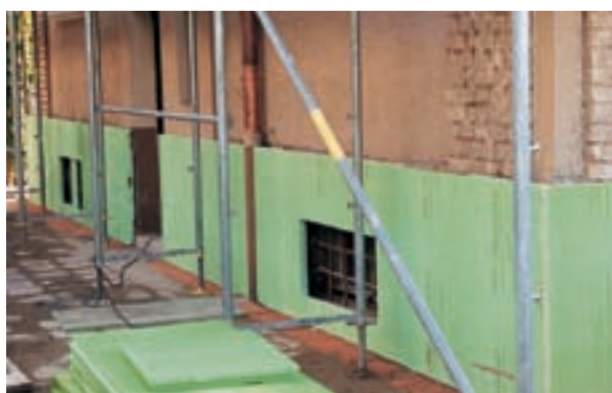
Fig. 17: Aislamiento adicional de zócalos con Styrodur 2800 C.
