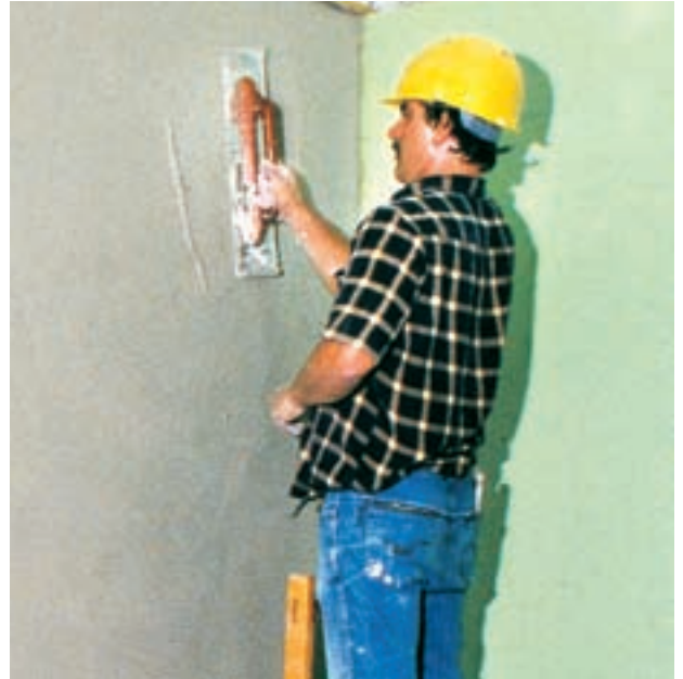
Fig. 34: Segunda capa de revestimiento de unos 5 mm de espesor. El revestimiento se realiza líquido sobre líquido.
