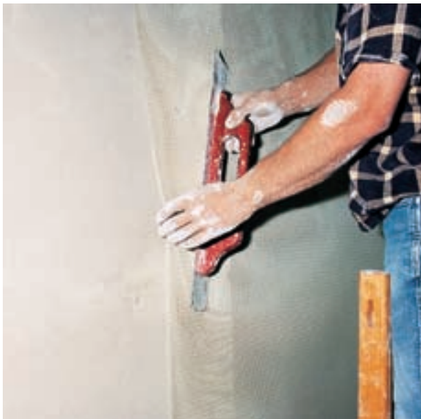
Fig. 33: Instalación completamente lisa del tejido reforzado de tejido de fibra de vidrio. Las tiras de tejido se solaparán unos 100 mm.
