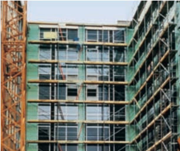
Fig. 7: Aislamiento de puentes térmicos con Styrodur® 2800 C.
