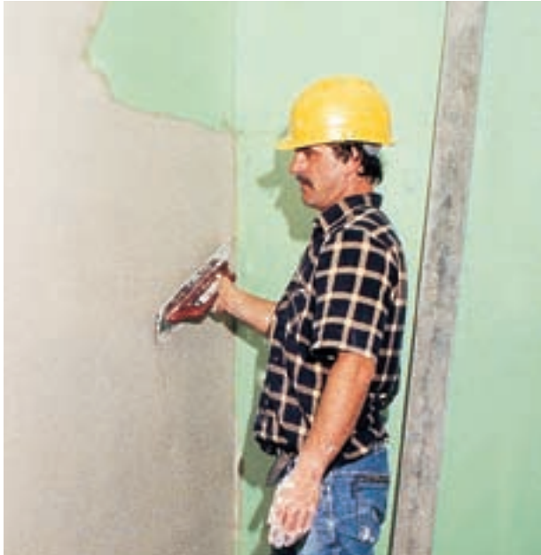
Fig. 32: Primera capa de revestimiento, espesor de la capa de 10 mm.
