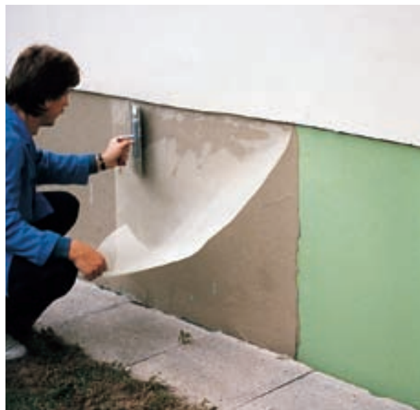
Fig. 29: Instalación de rejilla de cristal en el revoque del suelo del aislamiento del zócalo.
