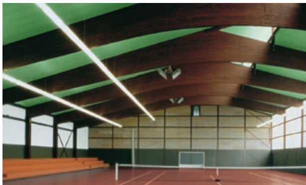
Fig. 1: Aislamiento de un pabellón deportivo con Styrodur® C.
