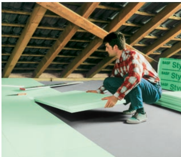
Fig. 4: Aislamiento de un techo con Styrodur® C.
