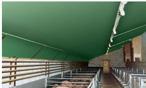
Fig. 3: Aislamiento de una granja.
