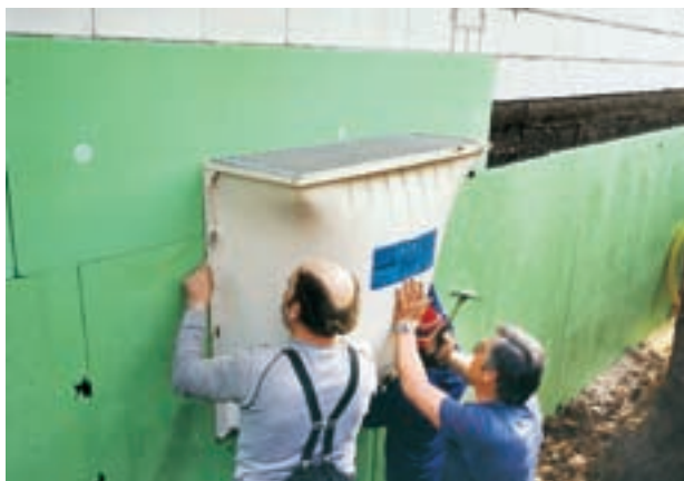
Fig. 3: Aislamiento perimetral con Styrodur® C.
