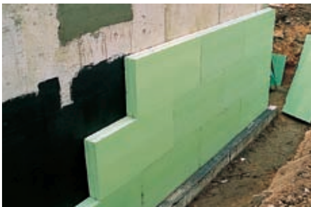
Fig. 5: Instalación de placas Styrodur® C unidas.
