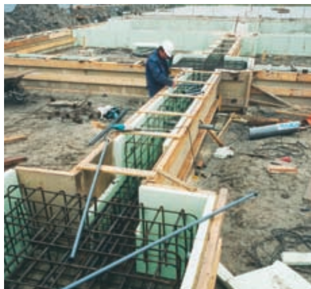
Fig. 15: Encofrado con Styrodur C.
