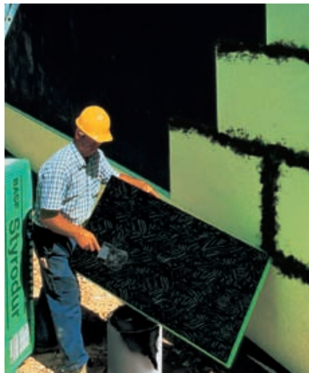
Fig. 25: Adhesión de toda la superficie de las planchas Styrodur® C y bordes de las planchas, así como intercalado de las juntas de las planchas en zona de aguas subterráneas.
