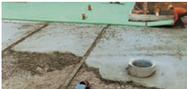
Fig. 18: Capa inferior granular de hormigón de limpieza para instalar el aislamiento del suelo.
