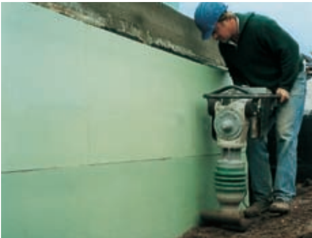
Fig. 26: Rellenado por capas de la zanja de cimentación y compactación mecánica.
