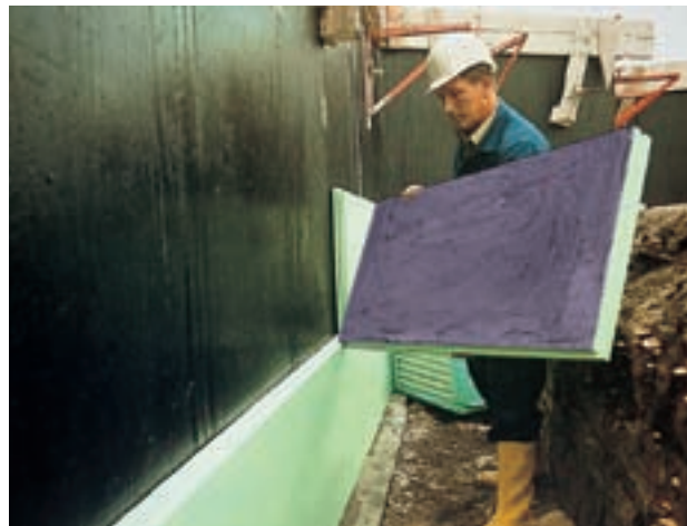
Fig. 6: Instalación de placas Styrodur C en las paredes exteriores del sótano.
