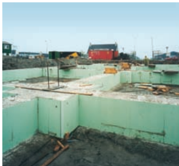
Fig. 16: Planchas de Styrodur C instaladas en un encofrado.
