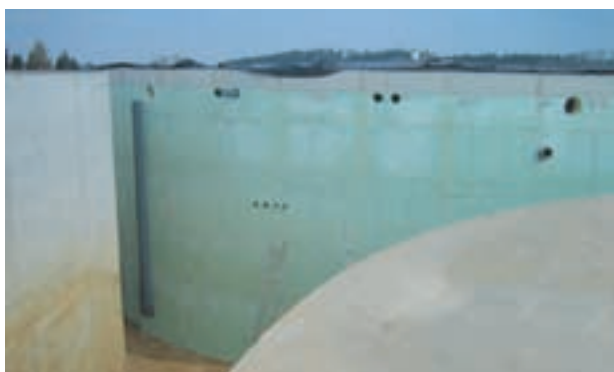
Fig. 1: Aislamiento térmico de Styrodur® C en la pared de un depósito de fermentación de hormigón armado.
