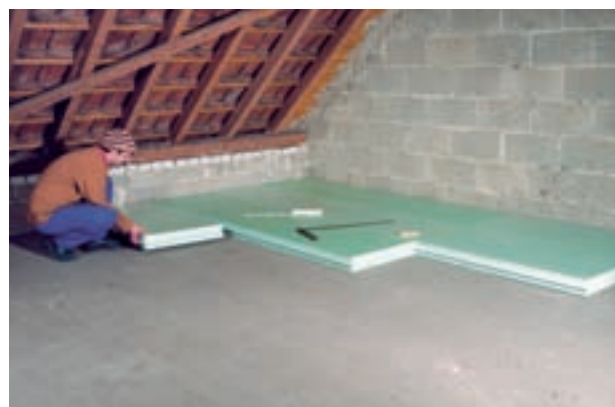
Fig. 2: Aislamiento del entretecho con Styrodur C.
