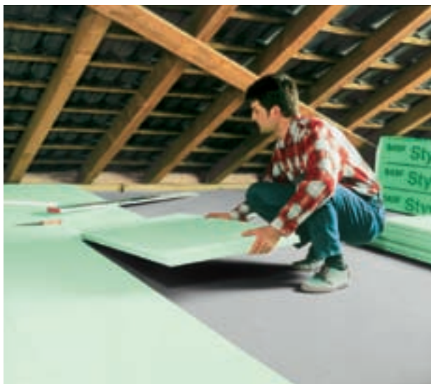
Fig. 10: Aislamiento de un techo con Styrodur® C.
