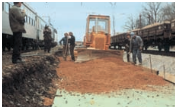
Fig. 8: Protección en la construcción del lecho de la vía con Styrodur C de alta resistencia a la compresión.
