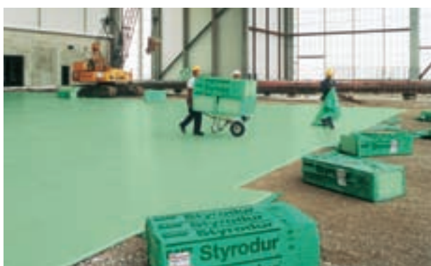
Fig. 23: Aislamiento del suelo de un pabellón con Styrodur® C.
