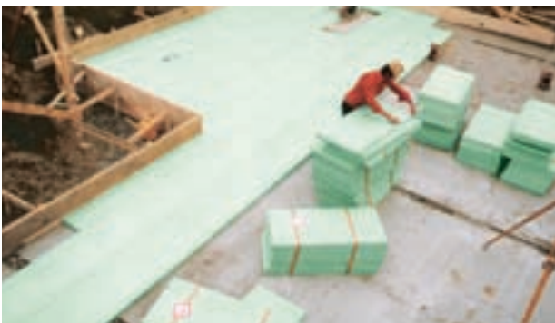
Fig. 4: Instalación de planchas Styrodur C.
