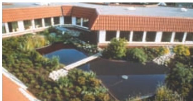
Fig. 6: Terraza ajardinada y transitable con agua en estanques sobre construcción de cubierta plana invertida con capa filtrante de grava.
