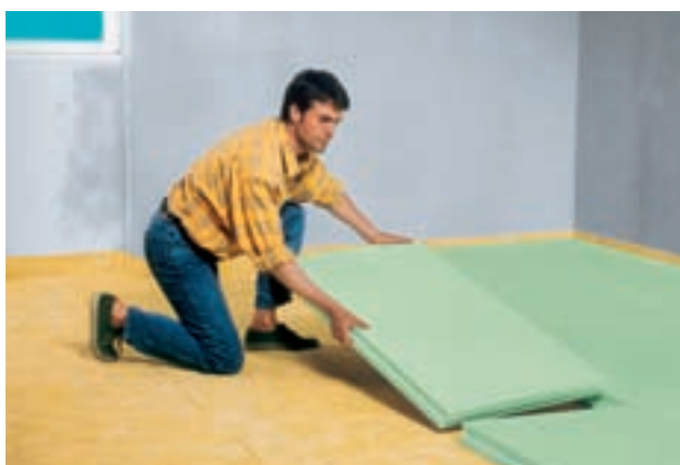
Fig. 20: Aislamiento de suelos con aislamiento al ruido de impacto con Styrodur® C.
