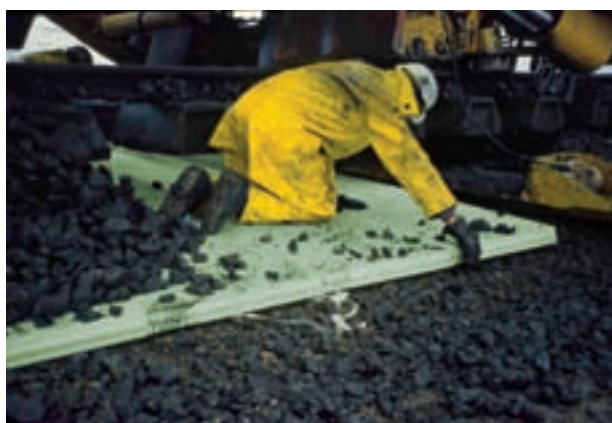
Fig. 9: Instalación de Styrodur C en el lecho de la vía.
