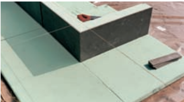
Fig. 3: Aislamiento de una losa de cimentación con Styrodur® C.
