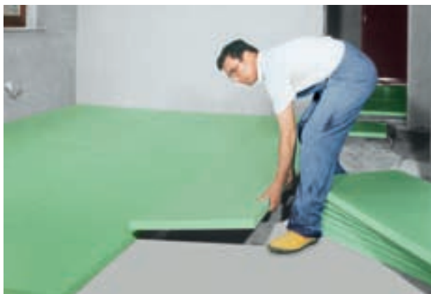
Fig. 19: Aislamiento del suelo de un sótano.
