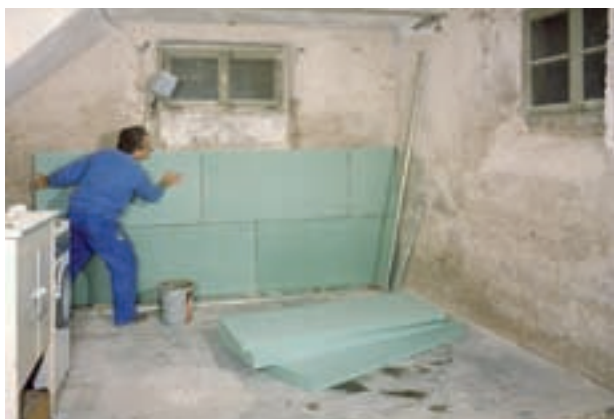
Fig. 27: Debido a sus propiedades, Styrodur® C también es adecuado para el aislamiento interior de sótanos.
