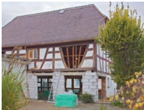
Fig. 26: Se utilizó Styrodur® C dentro de un proyecto de rehabilitación de la Agencia Alemana de Energía en el aislamiento del sótano de esta casa.
