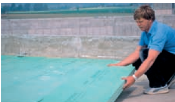
Fig. 4: Instalación de una capa de aislamiento térmico de Styrodur® C sobre la cubierta.
