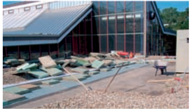
Fig. 1: Medidas de rehabilitación con Styrodur® C.
