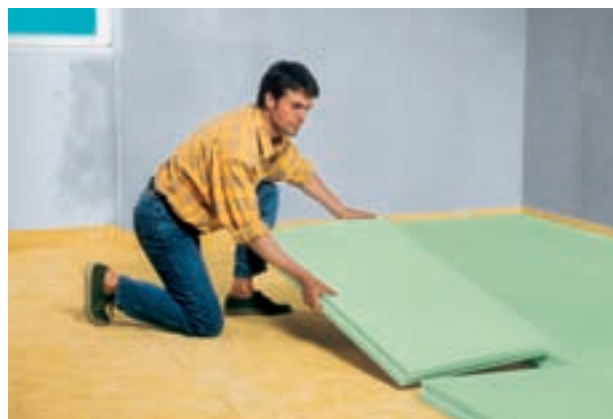
Fig. 28: Aislamiento de suelos con aislamiento al ruido de impacto con Styrodur C.
