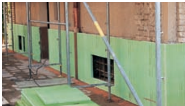
Fig. 19: Aislamiento de zócalos con Styrodur® 2800 C.
