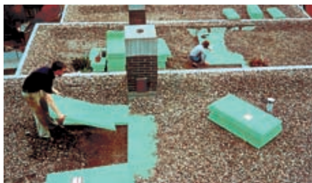
Fig. 5: Instalación de una capa de aislamiento bajo grava.
