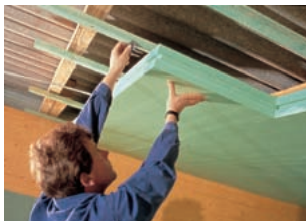
Fig. 12: Instalación de planchas Styrodur C.
