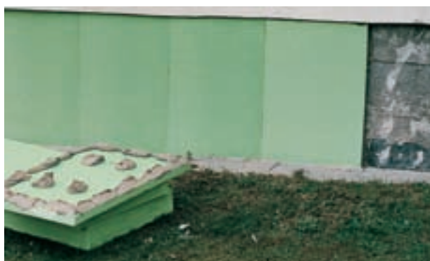
Fig. 21: Rehabilitación de edificios antiguos; Pegado de planchas de Styrodur 2800 C con procedimiento de pelladas.
