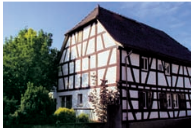
Fig. 2: Se utilizó Styrodur C dentro de un proyecto de rehabilitación en colaboración con la Agencia Alemana de Energía (DENA, en sus siglas en alemán) para la rehabilitación de este edificio con celosía.
