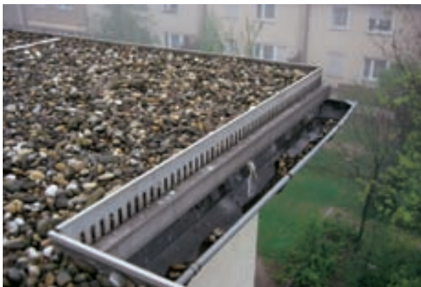
Fig. 7: Cubierta de grava sobre Styrodur® C.
