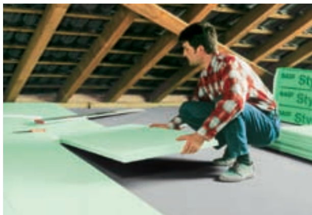
Fig. 8 : Isolation de combles avec le Styrodur C.
