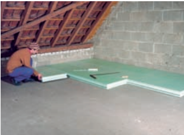
Fig. 5 : Isolation du comble avec du Styrodur® C épais.
