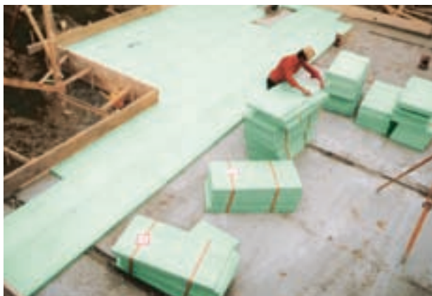
Fig. 7 : Pose de panneaux de Styrodur® C.
