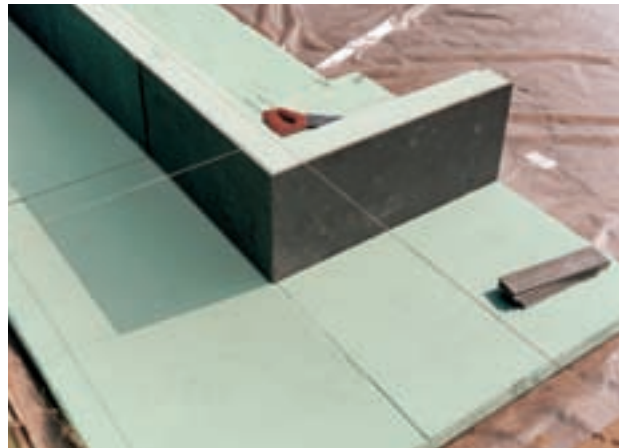
Fig. 6 : Isolation d'un panneau de fondation avec le Styrodur C.
