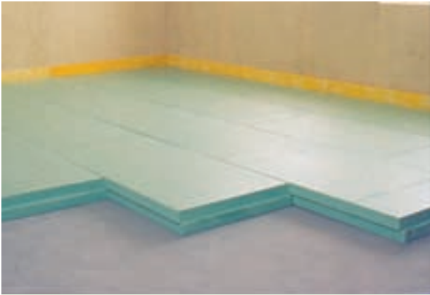
Fig. 10 : Isolation du sol avec le Styrodur® C.
