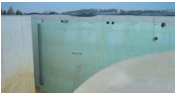
Fig. 1 : Isolation thermique en Styrodur® C sur la paroi d'un fermenteur en béton armé.
