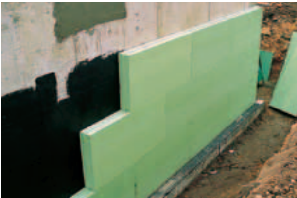
Fig. 5: Posa delle lastre di Styrodur® C allineate.
