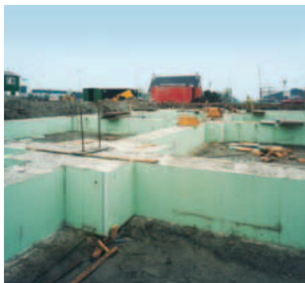
Fig. 16: Lastre di Styrodur 2800 C installate nella cassaforma.
