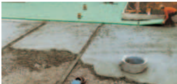
Fig. 18: Strato di protezione in calcestruzzo magro per la posa dell'isolamento del pavimento.
