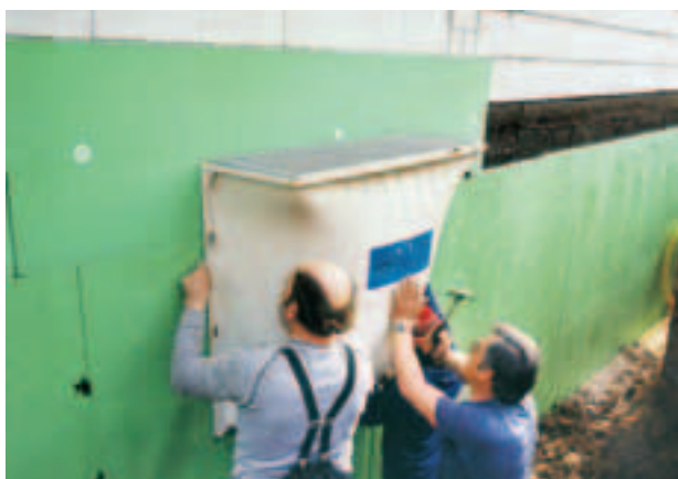
Fig. 3: Isolamento perimetrale con Styrodur® C.
