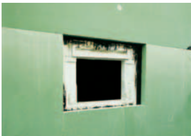
Fig. 4: Particolare dell'intervento di isolamento con Styrodur C.
