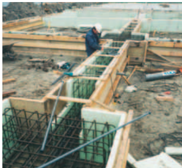
Fig. 15: Cassaforma con Styrodur 2800 C.
