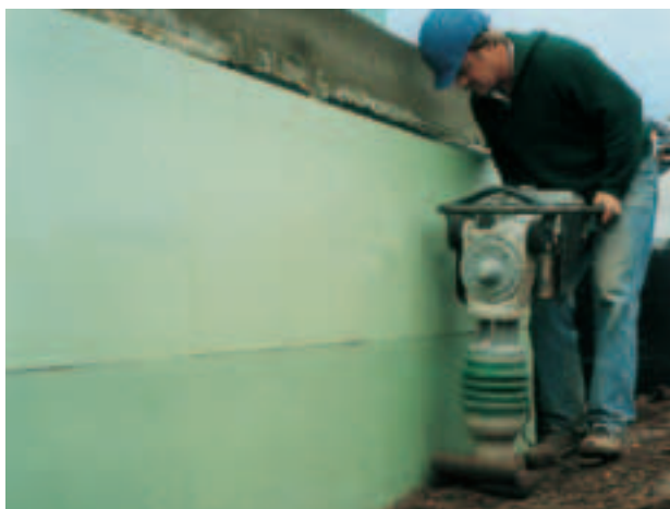
Fig. 26: Riempimento a strati dello scavo di fondazione e costipazione meccanica.
