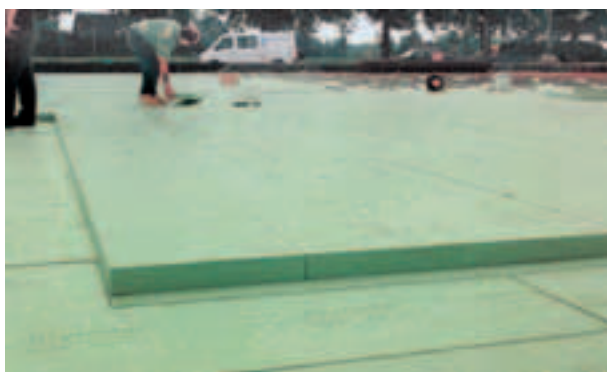
Fig. 29: Posa di lastre Styrodur® C durante la costruzione di una casa passiva.
