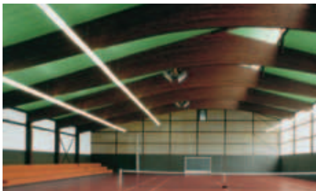
Fig. 1: Isolamento di una palestra con Styrodur® C.
