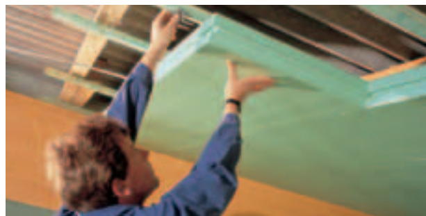
Fig. 7: Installazione di lastre in Styrodur C.
