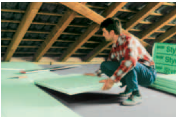
Fig. 4: Isolamento di un solaio con Styrodur® C.
