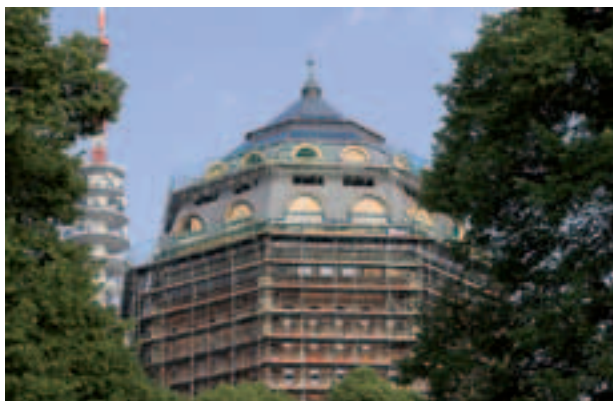
Fig. 1: Progetto di riferimento: Styrodur® C viene utilizzato come isolante nel tetto dell'acquedotto di Amburgo, nell'ambito delle misure di risanamento.
