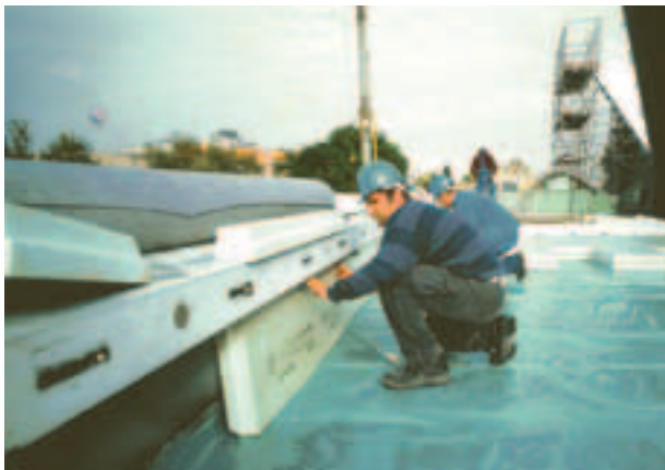
Fig. 15: Isolamento della veletta con Styrodur C.
