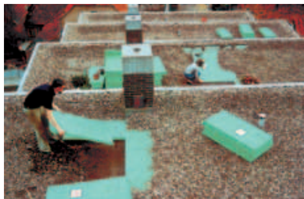
Fig. 2: Styrodur C, grazie alla sua resistenza alla compressione e alla ridotta conduttività termica, è particolarmente indicato per strutture di tetti rovesci.
