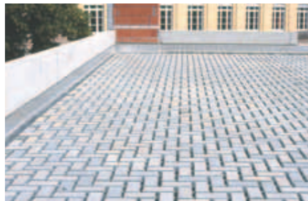
Fig. 50: Pavimentazione autobloccante in calcestruzzo su Styrodur® C.
