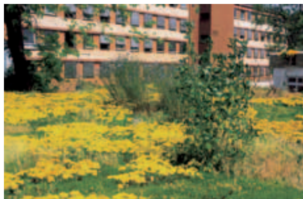
Fig. 21: Con un tetto verde su Styrodur® C si possono realizzare zone paesaggistiche urbane vive.
