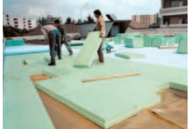
Fig. 14: Posa di Styrodur® C per tetto-duo.
