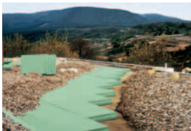
Fig. 18: Tetto rovescio risanato come struttura di tetto-plus.
