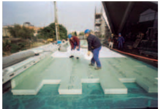
Fig. 16: Posa di Styrodur C sopra all'impermeabilizzazione del tetto.
