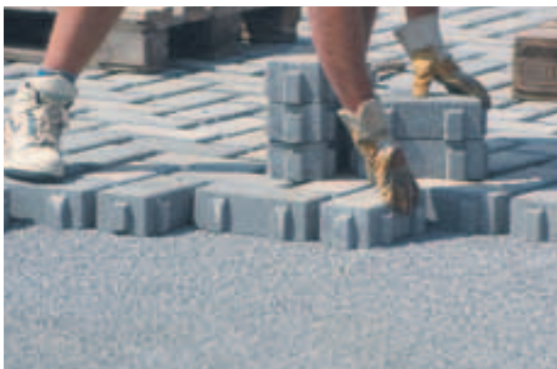
Fig. 49: Posa allineata di una pavimentazione autobloccante con giunzioni in erba per un parcheggio sulla palestra della scuola.
