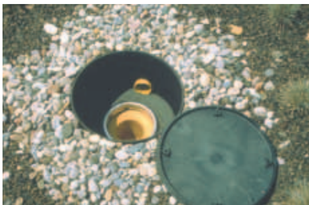
Fig. 10: Bocchetta di scarico del tetto.
