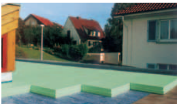
Fig. 26: Posa di lastre di Styrodur® C sotto a rinverdimento estensivo del tetto.
