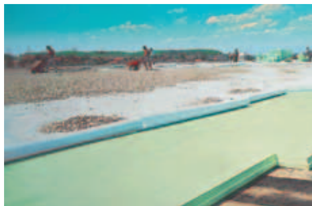
Fig. 11: Tetto rovescio con riporto di ghiaia.
