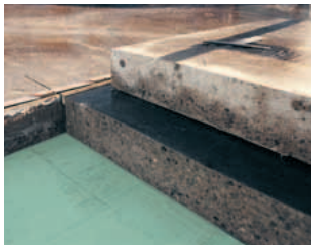
Fig. 53: Lastra della carreggiata in calcestruzzo gettato in opera per lo studio scientifico del comportamento nel lungo periodo.
