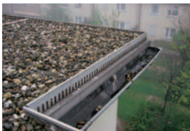
Fig. 19: Tetto a ghiaia.
