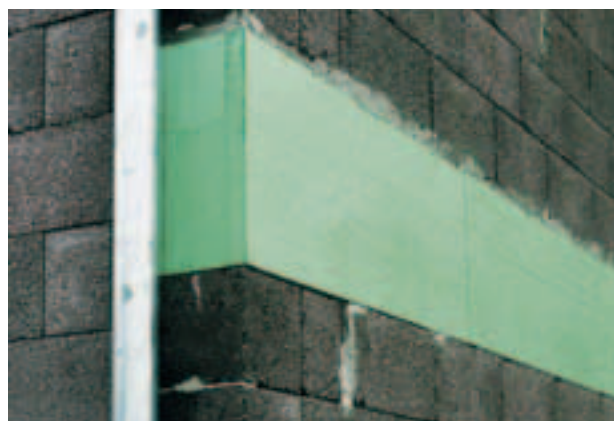
Fig. 2: Isolamento termico nel perimetro del solaio con Styrodur® 2800 C.
