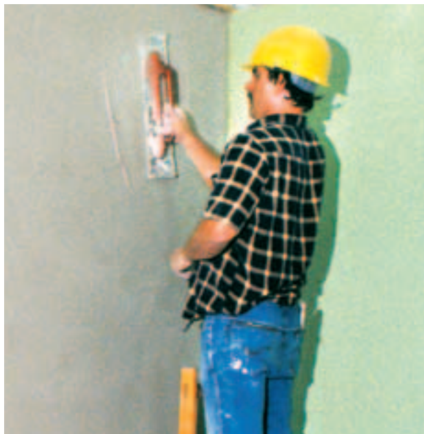
Fig. 34: Stesura del secondo strato di intonaco, spessore di circa 5 mm. L'applicazione dell'intonaco avviene bagnato su bagnato.
