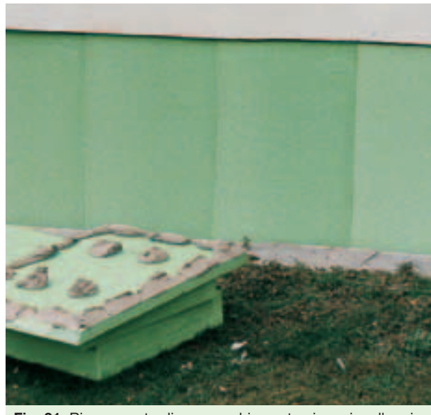
Fig. 31: Risanamento di una vecchia costruzione; incollaggio di lastre di Styrodur 2800 C con procedura di giunzione a punti sul bordo.
