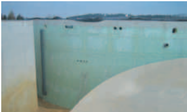
Fig. 1: Isolamento termico con Styrodur® C di una parete di fermentatore in calcestruzzo armato.
