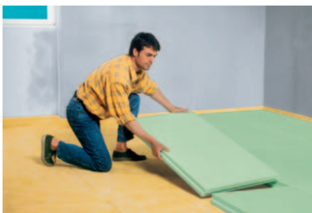
Fig. 20: Isolamento del pavimento con isolamento anticalpestio in EPS elasticizzato di locali abitativi con Styrodur® C.
