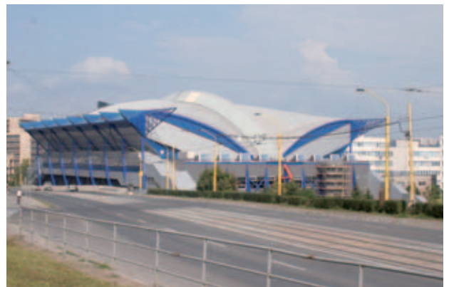
Fig. 17: Riferimento: Steel Arena a Košice (Slovacchia). Nel nuovo palazzetto per hockey su ghiaccio è stato posato Styrodur C sotto alla superficie della pista. Qui avrà luogo il Campionato mondiale di hockey sul ghiaccio nel 2011.
