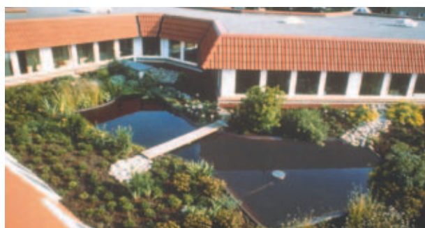
Fig. 6: Tetto verde a terrazza calpestabile con irrigazione a raccolta in stagni artificiali su una struttura di tetto rovescio con strato drenante di ghiaia su tutta la superficie.
