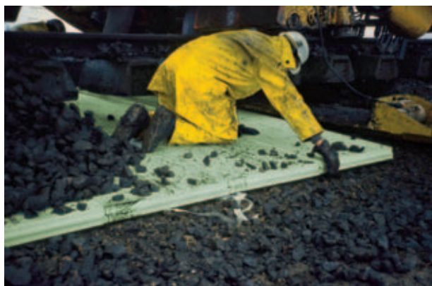
Fig. 9: Posa di Styrodur C nella massicciata ferroviaria.
