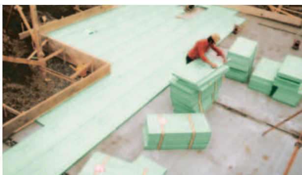
Fig. 4: Posa di lastre di Styrodur C.
