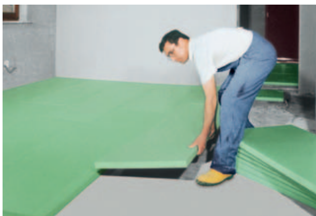
Fig. 19: Isolamento del pavimento della cantina.
