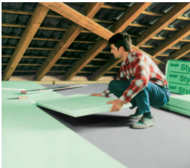
Fig. 10: Isolamento di un sottotetto con Styrodur® C.
