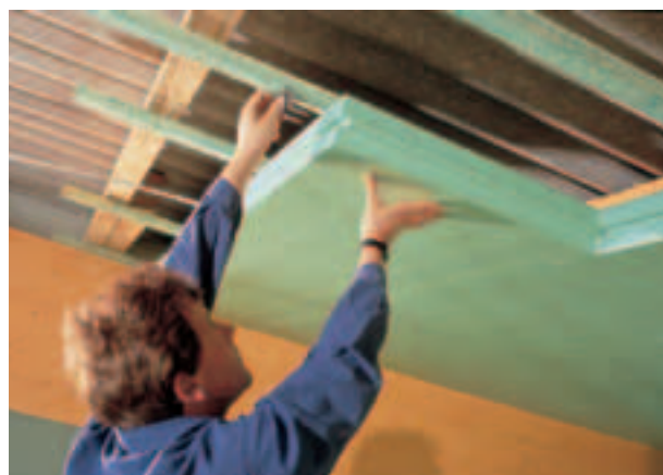
Fig. 12: Applicazione di lastre di Styrodur C.
