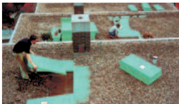
Fig. 5: Posa dello strato isolante sotto la ghiaia.
