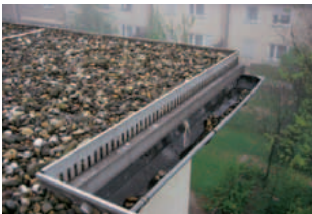
Fig. 7: Tetto con ghiaia su Styrodur® C.
