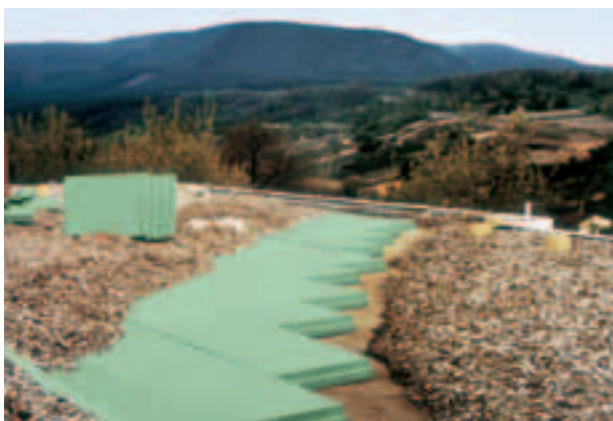
Fig. 6: Tetto rovescio risanato come struttura di tetto-plus.
