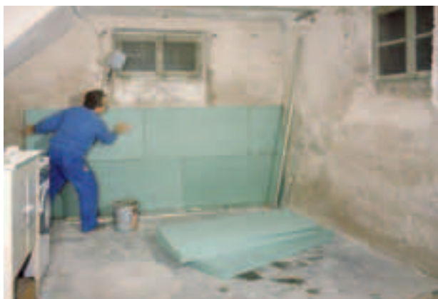
Fig. 27: Grazie alle sue proprietà, Styrodur® C è adatto anche per l'isolamento interno delle cantine.
