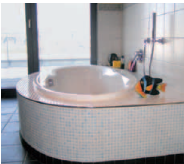
Fig. 17: Esempio applicativo di elementi per piastrellature in Styrodur C: vasca da bagno ( www.pr1mus.de ).
