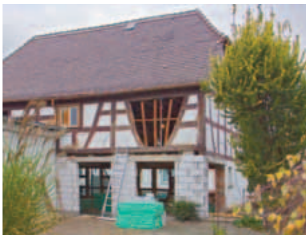
Fig. 26: Nell'ambito di un progetto di risanamento della Deutschen Energieagentur è stato usato Styrodur C per l'isolamento del pavimento di questo edificio.
