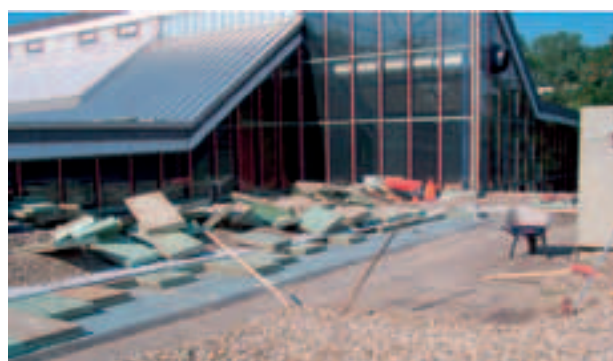
Fig. 1: Intervento di risanamento con Styrodur® C.
