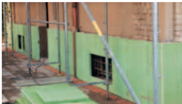
Fig. 19: Successivo isolamento dello zoccolo con Styrodur® 2800 C.
