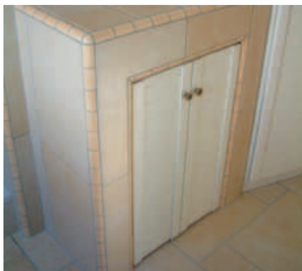
Fig. 18: Esempio applicativo di elementi per piastrellature in Styrodur C: piano di mobile da bagno ( www.pr1mus.de ).
