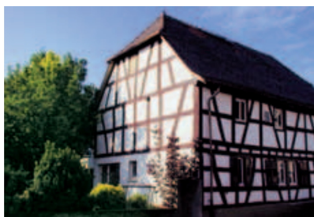
Fig. 2: Impiego di Styrodur C nell'ambito del progetto di risanamento di un edificio con travi a tralici, in collaborazione con la Deutschen Energieagentur.
