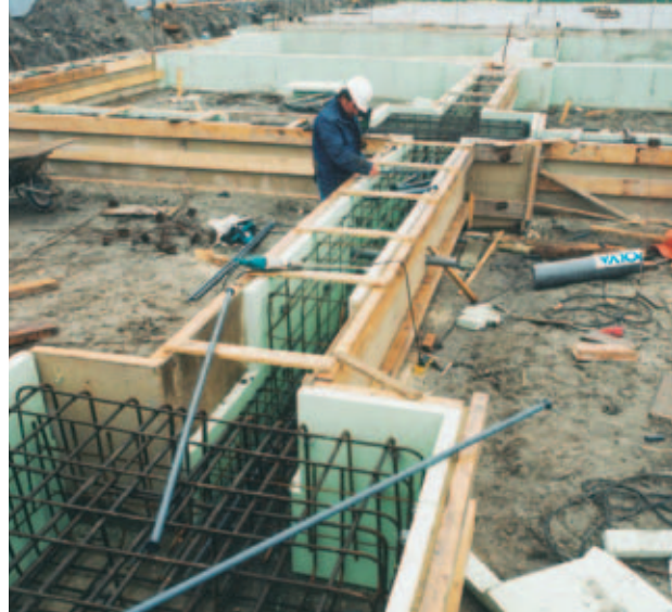
Afb. 13: Bekisting met Styrodur C.
