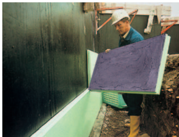
Afb. 4: Opzetten van de Styrodur C platen op de betonnen plint.
