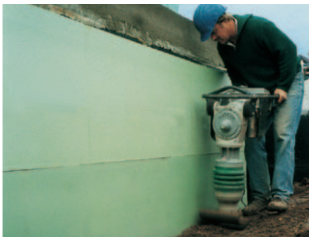
Afb. 24: Vullen in lagen en mechanisch verdichten van de grond.
