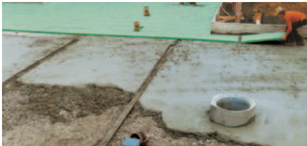
Afb. 16: Werkvloer uit beton voor het leggen van de vloerisolatie.
