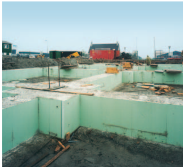
Afb. 14: Geïsoleerde funderingsbalk na ontkisten
