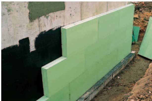
Afb. 3: Verwerken van Styrodur® C platen in halfsteensverband.
