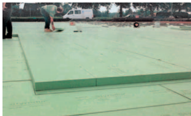
Afb. 26: Styrodur® C vloerisolatie voor een Passief Huis.
