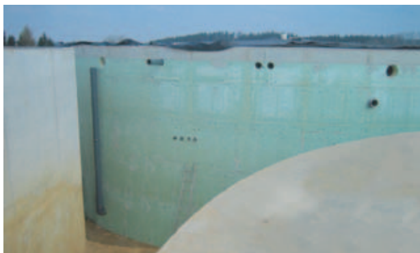
Afb. 1: Thermische isolatie met Styrodur® C op een vergisterwand van staalbeton.
