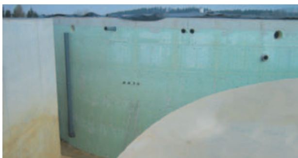
Ilustr. 1: Docieplenie ze Styroduru® C żelbetowej ściany fermentora.
