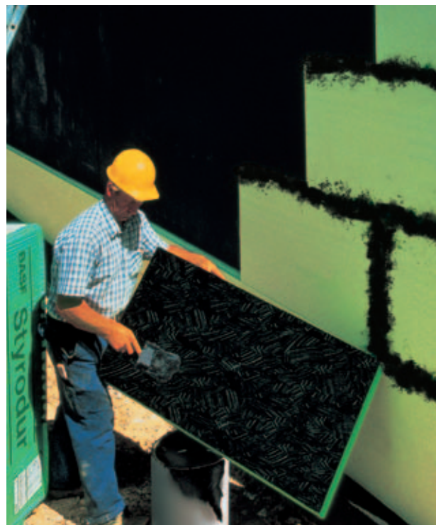
Rys. 25: Przyklejanie płyt Styrodur® C na całej powierzchni, łącznie z brzegami, i szpachlowanie spoin płyt w strefie wody gruntowej.
