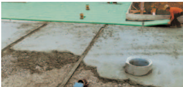
Rys. 18: Warstwa wyrównawcza z betonu chudego pod izolacją posadzki.
