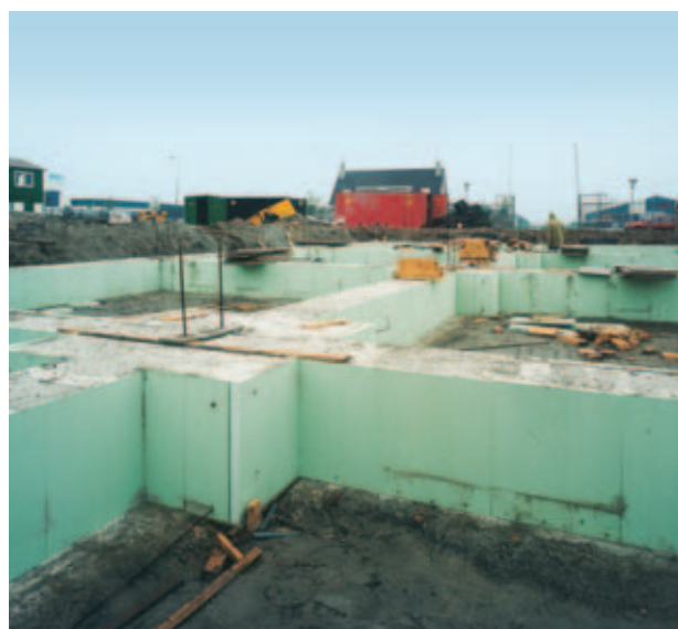
Rys. 16: Płyty Styrodur C wstawiane w deskowanie.
