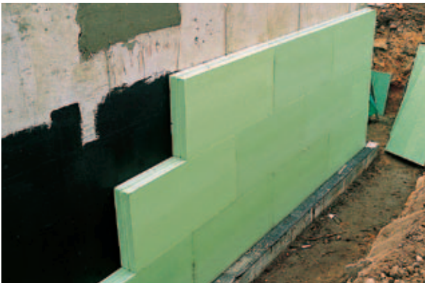
Rys. 5: Układanie płyt Styrodur® C z przewiązaniem spoin.
