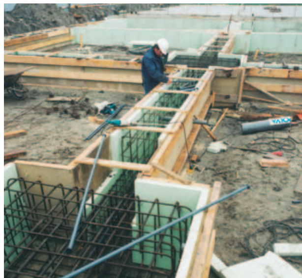
Rys. 15: Szalowanie za pomocą Styrodur C.
