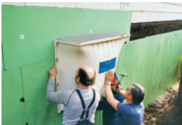
Rys. 3: Izolacja obwodowa za pomocą Styrodur® C.
