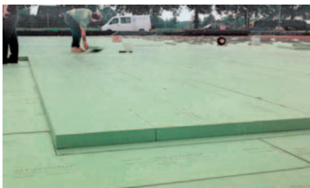
Rys. 29: Układanie płyt Styrodur® C przy wznoszeniu domu pasywnego.
