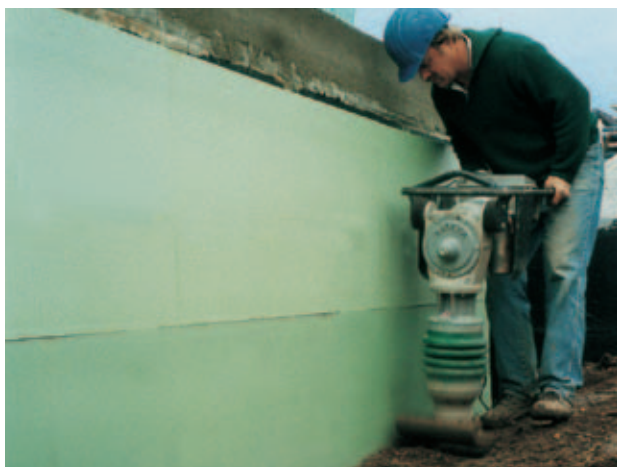
Rys. 26: Wypełnianie wykopu warstwami z zagęszczaniem mechanicznym.
