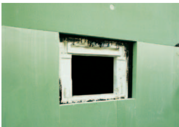
Rys. 4: Roboty izolacyjne przy użyciu Styrodur C.
