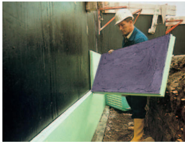
Rys. 6: Osadzanie płyt Styrodur C na zewnętrznej ścianie piwnicy.
