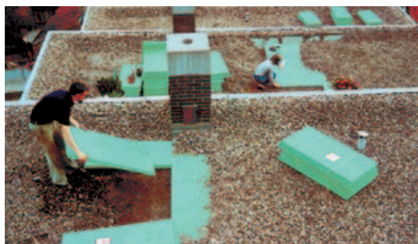
Rys. 5: Układanie warstwy izolacyjnej pod żwir.
