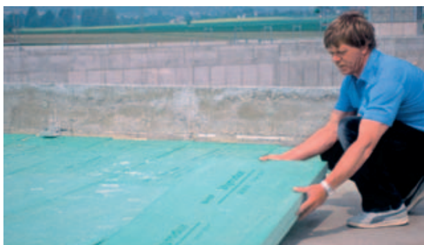
Rys. 4: Układanie warstwy izolacyjnej z Styrodur® C na dachu.
