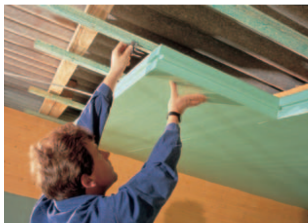
Rys. 12: Nanoszenie płyt Styrodur C.
