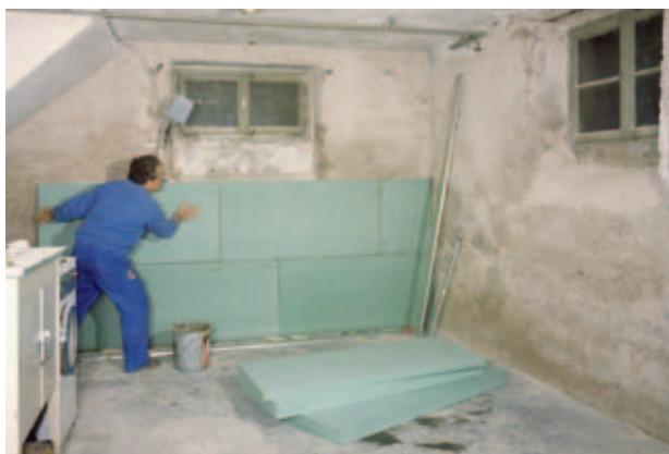
Rys. 27: Ze względu na swe własności Styrodur® C nadaje się także do ocieplania wewnętrznego pomieszczeń piwnicznych.
