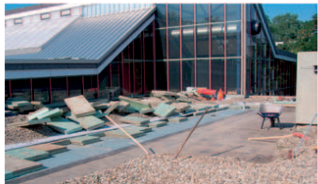
Rys. 1: Renowacja przy zastosowaniu Styrodur® C.
