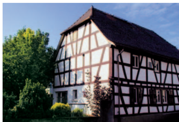
Rys. 2: W ramach projektu renowacyjnego w kooperacji z Niemiecką Agencją Energii dena do renowacji tego domu o konstrukcji szkieletowej zastosowano Styrodur C.
