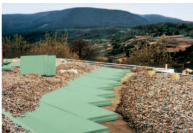
Rys. 6: Zmodernizowany dach odwrócony o konstrukcji Plus.
