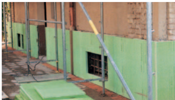
Rys. 19: Dodatkowe ocieplenie cokołu za pomocą Styrodur® 2800 C.
