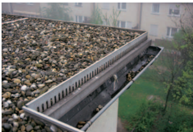
Rys. 7: Dach żwirowany z izolacją Styrodur® C.
