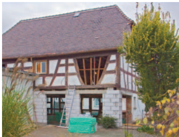
Rys. 26: W ramach projektu renowacyjnego w kooperacji z Niemiecką Agencją Energii dena zastosowano Styrodur® C do renowacji tego domu o konstrukcji szkieletowej.
