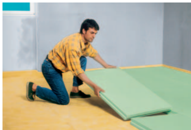
Rys. 28: Ocieplanie podłóg w pomieszczeniach mieszkalnych z izolacją przed dźwiękiem uderzeniowym za pomocą Styrodur C.
