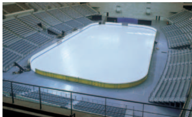
Rys. 16: Zastosowanie Styrodur C pod taflą lodowiska.
