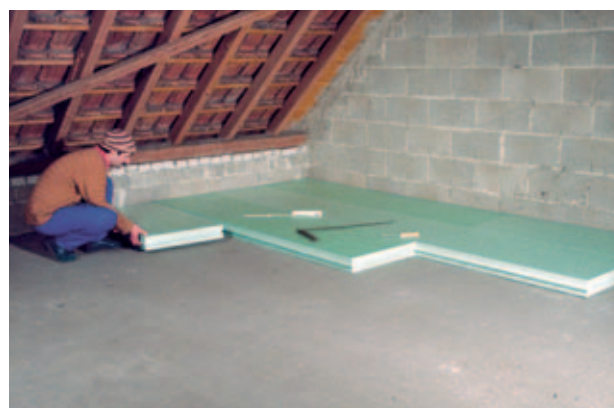
Rys. 2: Ocieplanie strychu płytami Styrodur C.
