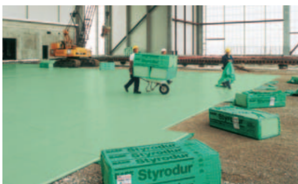
Rys. 23: Ocieplenie posadzki hali za pomocą Styrodur® C.
