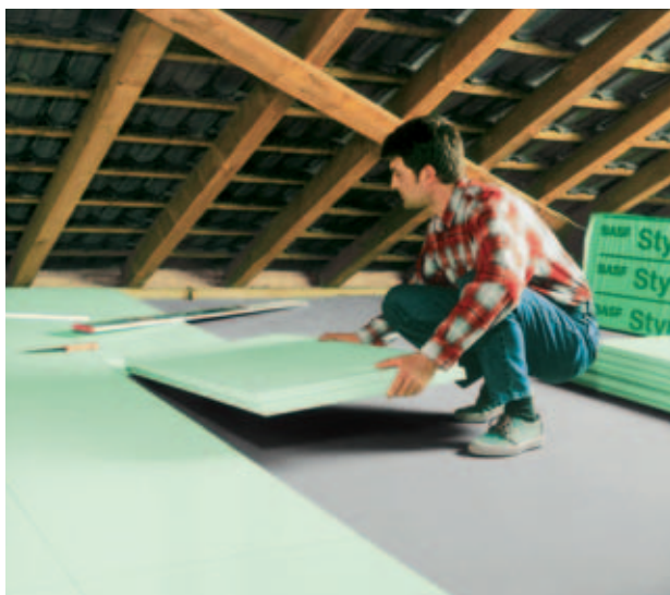
Rys. 10: Ocieplanie strychu materiałem Styrodur® C.
