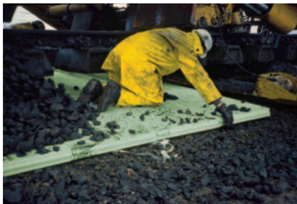
Rys. 9: Układanie Styrodur C w podłożu toru.
