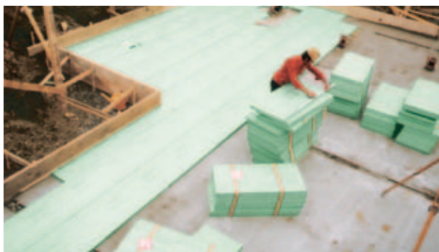
Rys.4: Układanie płyt Styrodur C
