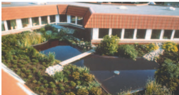
Rys. 6: Zielony taras dachowy, przeznaczony do chodzenia, z nawodnieniem spiętrzeniowym w oczkach foliowych na konstrukcji dachu odwróconego z drenażową warstwą żwiru na całej powierzchni.
