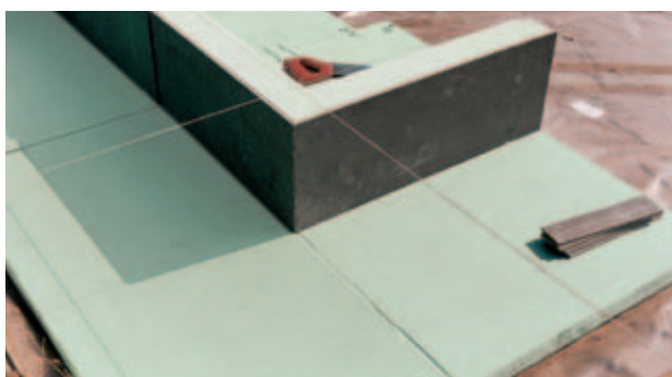
Rys. 3: Ocieplanie płyty fundamentowej materiałem Styrodur® C.
