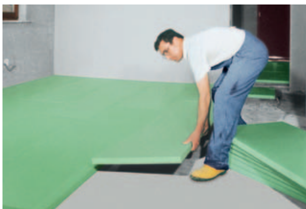
Rys. 19: Ocieplanie posadzki piwnicy.
