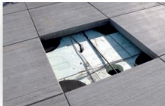
Bild 5: Im Hohlraum zwischen Fahrbahnplatte und Dämmung bleibt ausreichend Raum zur Verlegung des Blitzschutzes oder elektrischer Steuer- und Versorgungsleitungen.
