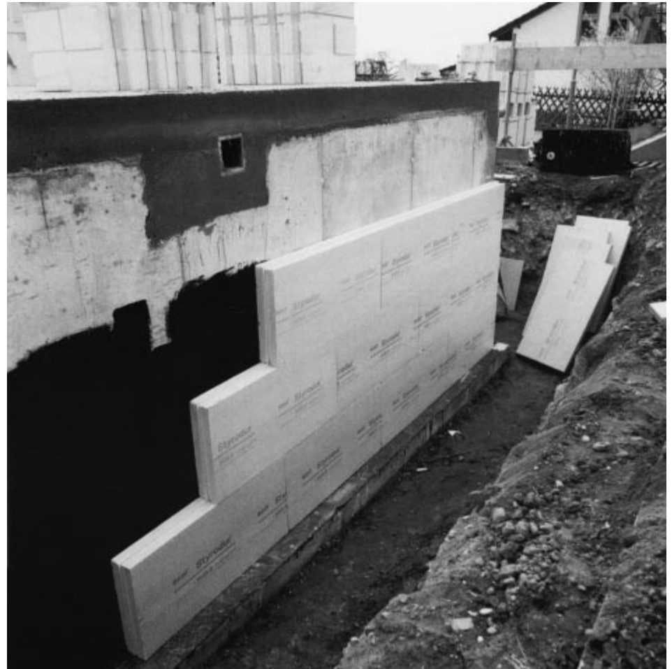
Bild 7 (unten): Verlegung der XPS-Perimeterdämmplatten mit versetzten Fugen.
