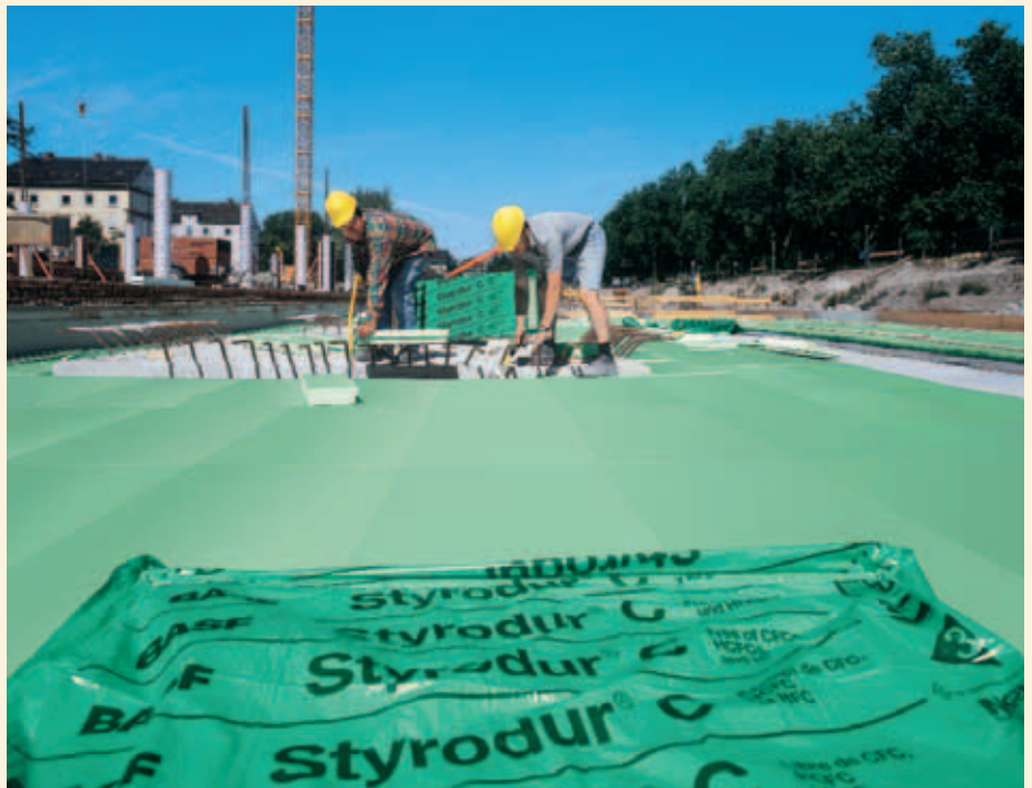
Abb. 1: Lastabtragende Wärmedämmung im Gründungsbereich.
