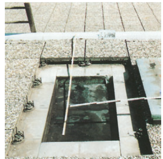
Abb. 6: Terrassendach T 1. Freigelegte ECB-Abdichtung in einwandfreiem Zustand.
