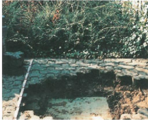
Abb. 19: Parkdach P 6. Öffnung des Betonverbundsteinpflasters. Nach 15-jähriger Nutzung befindet sich das Pflaster in einwandfreiem Zustand.
