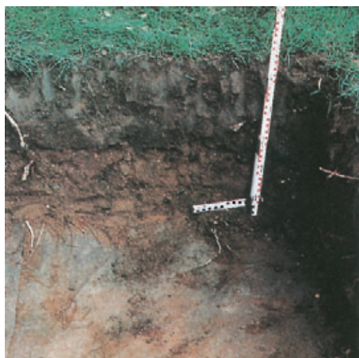
Abb. 25: Gründach G 3. 30 cm »fetter« Mutterboden und 20 cm Kiessand auf dem Vlies, darunter 10 cm Schlackesand auf der Dämmschicht.
