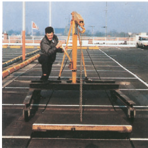
Abb. 11: Parkdach P 2. Einfaches Herausheben der 2,9 m 2 großen Betonplatten mit vier anbetonierten Stelzen 25 x 25 cm 2 .
