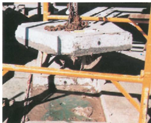
Abb. 16: Parkdach P 3. Herausheben eines herausgetrennten Teils aus der 16 cm dicken Betonplatte, die auf der Dämmschicht aufbetoniert ist.
