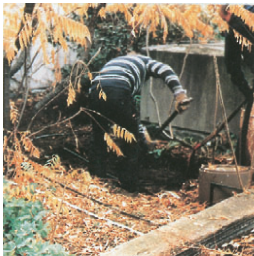
Abb. 21: Gründach G 1. Öffnen der Probeentnahmestelle. Pflanzsubstrat locker, von vielen Wurzeln durchwachsen.
